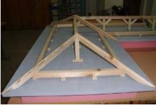
Şekil 3.15: Kırık Çatı Mahya Profillerinin Montajı
