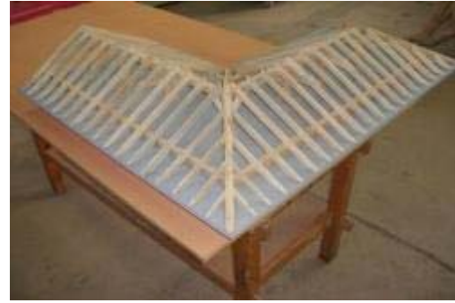
Şekil 3.19: Açılı Merteklerin Montajı
