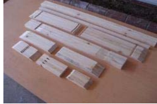
Şekil 2.13: Ahşap Makas Elemanlarının Hazırlanmış Hali
