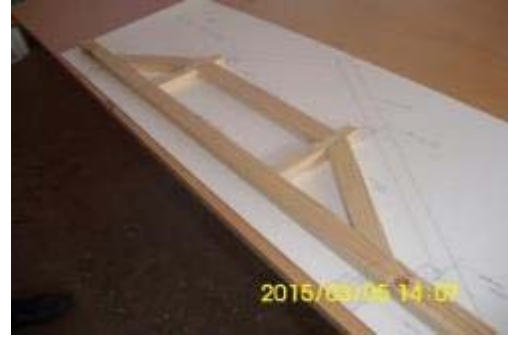
Şekil 2.35: Makas Elemanlarının Birbirine Alıştırılması
