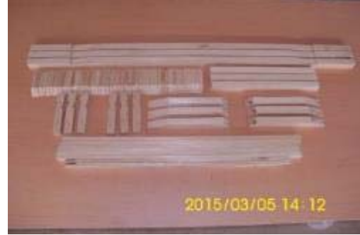
Şekil 2.34: Ahşap Makas Elemanlarının Hazırlanmış Hali
