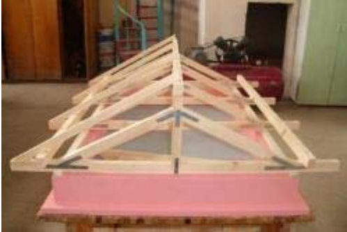
Şekil 2.27: Merteklerin Yerleştirilmesi
