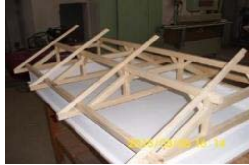
Şekil 2.44: Merteklerin Yerleştirilmesi
