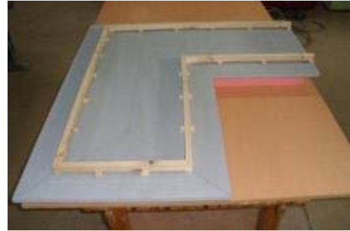
Şekil 3.9: Damlalık Aşıklarının Montajı
