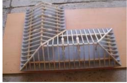
Şekil 3.22: Taşıyıcı Sistemi Tamamlanmış Oturtma Çatı Maketi
