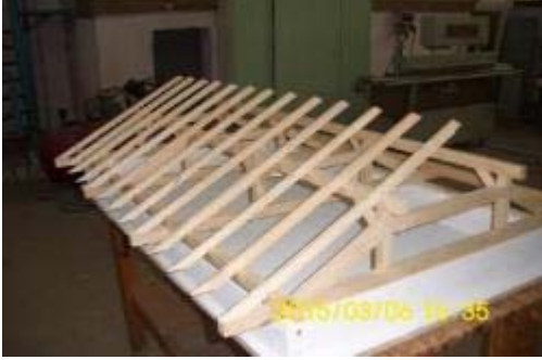
Şekil 2.45: Ara Merteklerin Yerleştirilmesi
