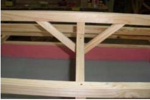
Şekil 2.26: Göğüslemelerin Yerleştirilmesi
