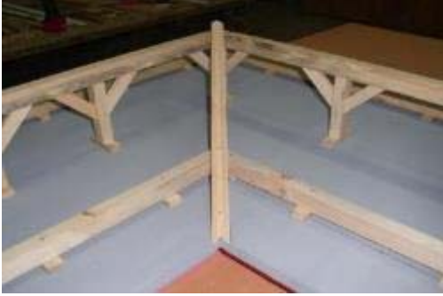
Şekil 3.14: Dere ve Eğik Mahya Profillerinin Montajı
