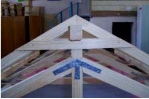
Şekil 2.30: Kuşakların Montajı
