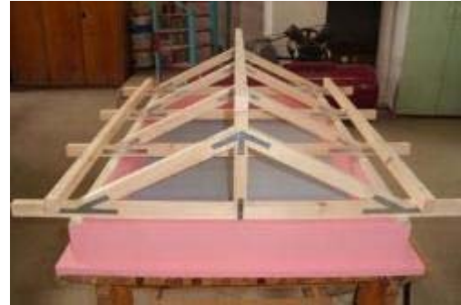
Şekil 2.25: Aşıkların Yerleştirilmesi
