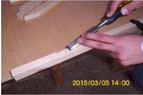
Şekil 2.33: Makas Elemanlarının Kesilmesi ve Oyulması
