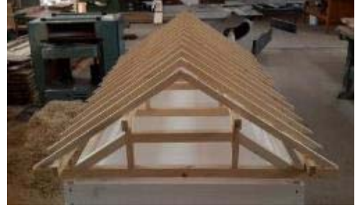
Şekil 2.46: Sağ Taraf Merteklerinin Yerleştirilmesi
