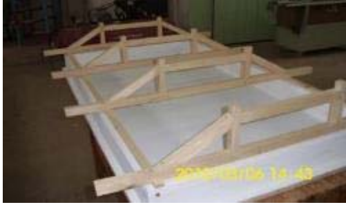
Şekil 2.41: Makasların Yerleştirilmesi
