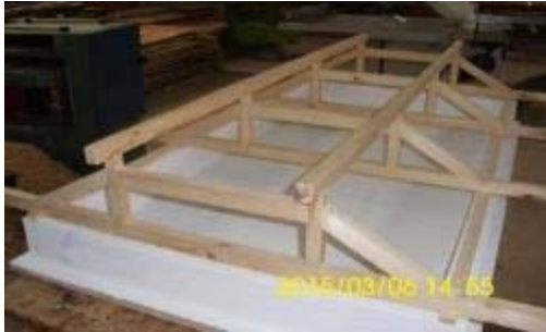
Şekil 2.42: Aşıkların Yerleştirilmesi
