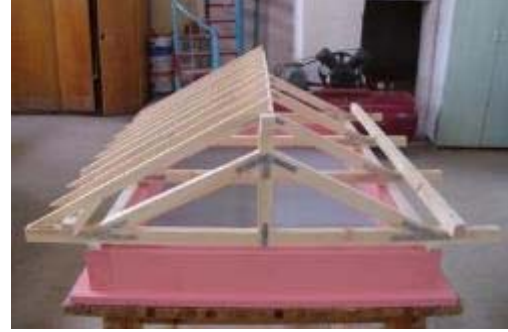
Şekil 2.28: Ara Merteklerin Yerleştirilmesi
