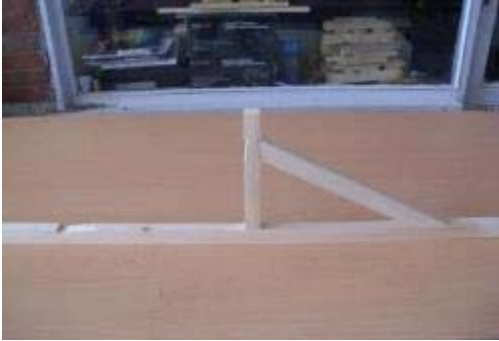
Şekil 2.15: Makas Sağ Diyagonalinin Yerleştirilmesi
