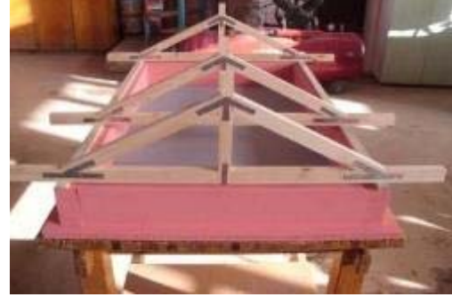
Şekil 2.24: Makasların Yerleştirilmesi
