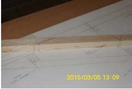
Şekil 2.11: Makas Elemanının Markalanması
