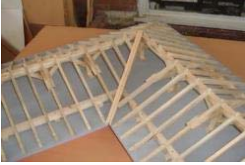
Şekil 3.21: Dere Mahya Profillerinin Montajı
