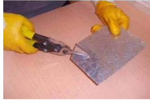
Şekil 2.21: Metal Yardımcı Elemanların Kesilmesi
