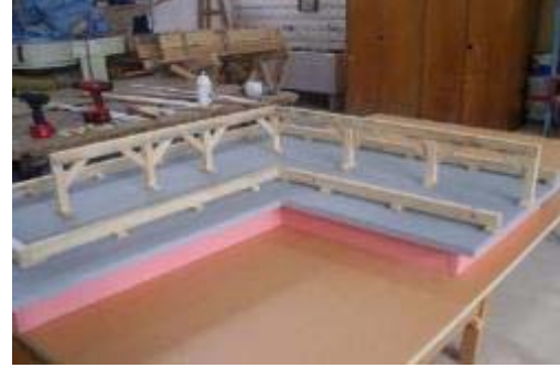
Şekil 3.12: Göğüslemelerin Montajı
