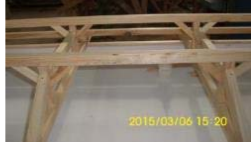
Şekil 2.43: Göğüslemelerin Yerleştirilmesi
