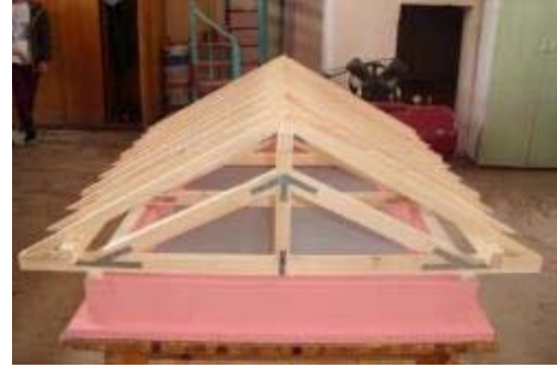
Şekil 2.29: Sađ Taraf Merteklerinin Yerleştirilmesi
