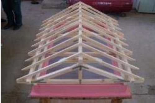
Şekil 2.30: Taşıyıcı Sistemi Tamamlanmış Tek Askılı Asma Çatı Maketi
