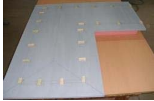
Şekil 3.8: Çatı Yastıklarının Montajı
