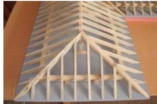
Şekil 3.20: Kıрма Çatı Merteklerinin Montajı
