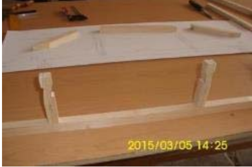
Şekil 2.36: Makas Dikmelerinin Yerleştirilmesi
