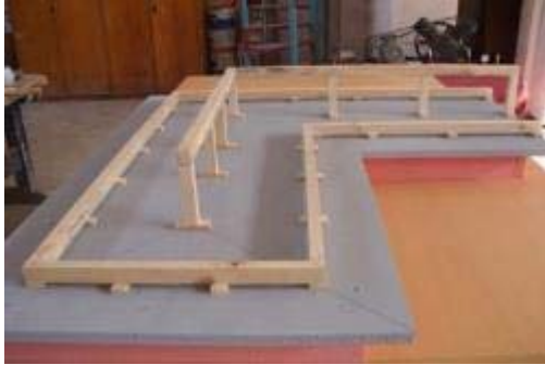
Şekil 3.11: Mahya Aşıklarının Yerleştirilmesi
