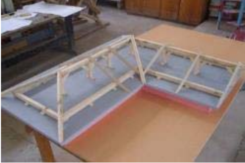
Şekil 3.16: Merteklerin Montajı
