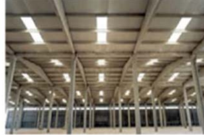
Resim 5.2: Çatıda CTP Uygulama Örnekleri
