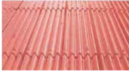
Resim 2.1: Çimento Esaslı Oluklu Çatı Kaplaması
