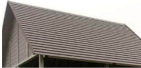
Resim 5.4: Ahşap Çatı Kaplaması
