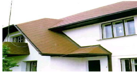
Resim 4.4: Shingle Kaplama Uygulaması
