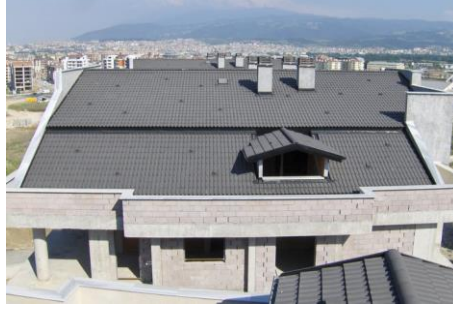
Resim 1.12: Beton Kaplama Uygulaması
