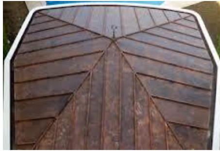
Resim 1.10: Bakır Kaplama Uygulaması
