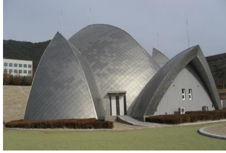
Resim 1.9: inko Kaplama Uygulaması
