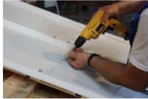
Resim 5.24: Bini Noktasında Panellerin Montajlanması
