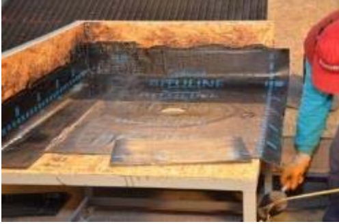
Resim 4.19: Süzgeç Boşluđunun Oluşturulması
