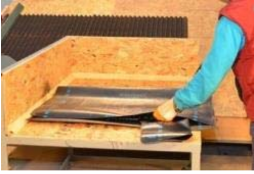
Resim 4.8: Bitümlü Su Yalıtım Örtüsünün Kesilmesi
