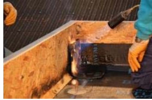
Resim 4.14: Şaloma Alevi ile Köşe Noktalarına Yalıtım Örtüsü Uygulaması
