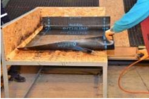
Resim 4.11: Bitümlü Su Yalıtım Örtüsünün Kenar Noktalarının Çatı Yüzeyine Yapıştırılması
