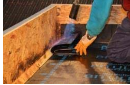
Resim 4.13: Köşe Nokta Uygulaması
