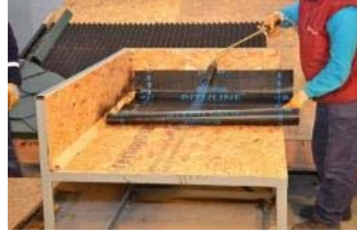
Resim 4.10: Bitümlü Su Yalıtım Örtüsünün Çatı Yüzeyine Yapıştırılması
