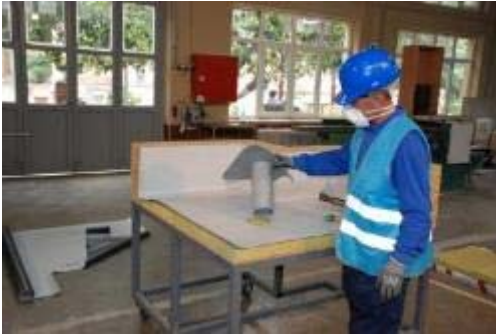
Resim 6.13: PVC Düşey Süzgecin Yerleştirilmesi
