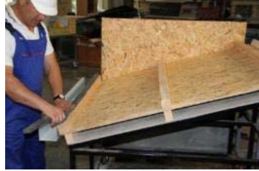
Resim 5.12: Dere Profilinin Üzerine Bitümlü Sünger Yapıştırılması
