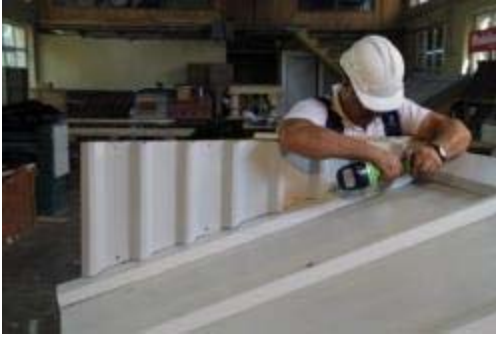
Resim 5.01: Trapez Sacın Parapet Duvarına Montajı
