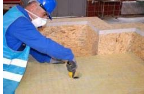
Resim 6.7: Süzgeç Boşluğunun Oluşturulması
