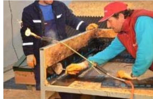
Resim 4.18: Mala Yardımı ile Kenar Yapıştırma
