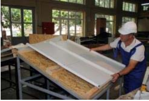
Resim 5.22: Bindirme Yapılacak Olan Panellerin Kontrolünün Yapılması
