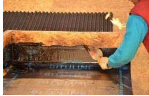
Resim 4.17: Mala Yardımı ile Kenar Yapıştırma
