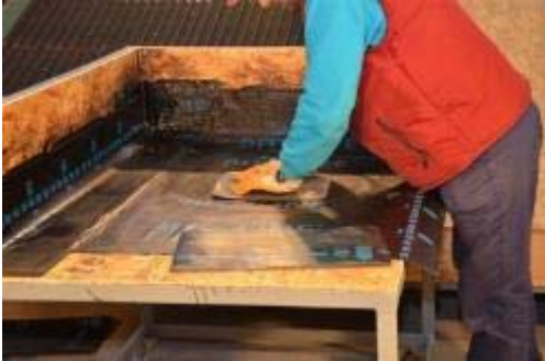
Resim 4.20: Düşey Yağmur Giderinin Yerleştirilmesi
