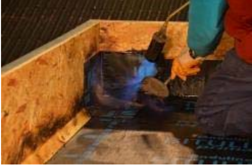
Resim 4.15: Şaloma Alevi ile Köşe Noktalarına Yalıtım Örtüsü Uygulaması Mala yardımcı ile ısıtılan örtünün üzerine iyice bastırılarak uygulama yapılır.
