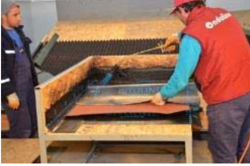
Resim 4.23: Mineral Kaplı Yalıtım Örtüsünün Alt Katmana Yapıştırılması
