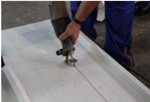
Resim 5.15: Isı Yalıtımlı Panelin Kesilmesi
