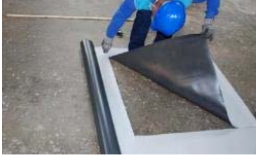
Resim 6.5: PVC Örtünün Kesilmesi
