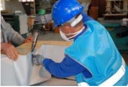
Resim 6.9: PVC Örtünün Laminasyon Çıtasına Yapıştırılması
