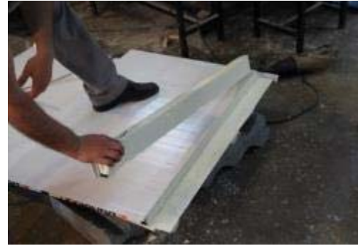
Resim 5.20: Bindirme Yapılacak Olan Panelin Kesilmesi
