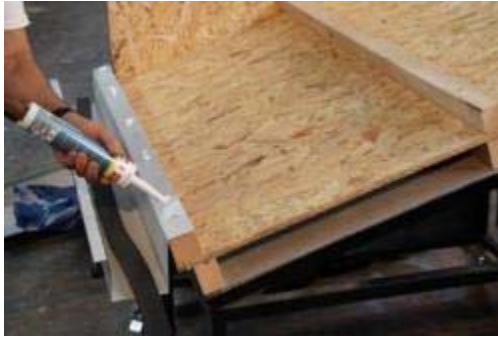
Resim 5.11: Dere Profilinin Üzerine Bitümlü Sünger Yapıştırılması
