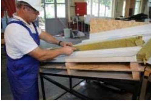
Resim 5.25: Mahya Noktasına Yerleřtirilecek Tařyünün Hazırlanması
