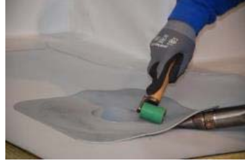
Resim 6.14: PVC Düşey Süzgecin Montajı
