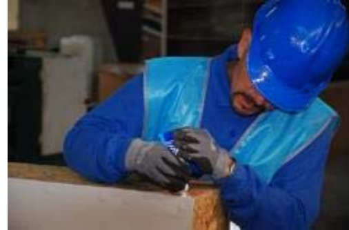
Resim 6.15: Laminasyon Çıtası Silikon Uygulaması
