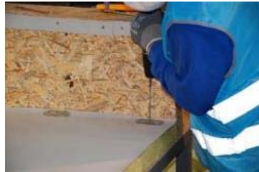
Resim 6.8: Raptetler ile PVC Örtünün Montajlanması
