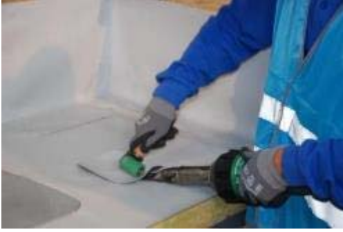
Resim 6.16: Laminasyon Çıtası Silikon Uygulaması Uygulaması
