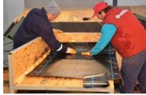
Resim 4.9: Bitümlü Su Yalıtım Örtüsünün Duvar Yüzeylerine Yapıştırılması
