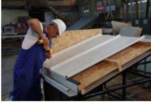
Resim 5.14: Isı Yalıtımlı İlk Panelin Montajı
