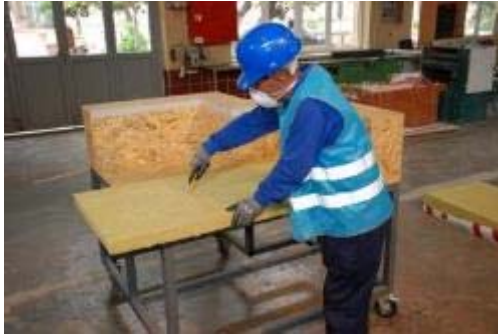
Resim 6.6: Taşıyününün Yerleştirilmesi
