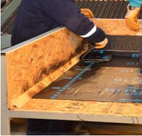
Resim 4.12: Köşe Noktaları İçin Yalıtım Örtüsünün Hazırlanması
