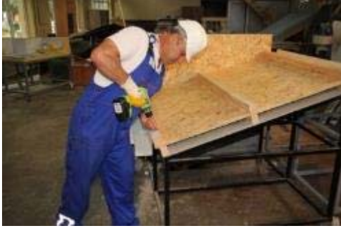
Resim 5.10: Dere Aşıđının Üzerine Dere Profilinin Montajlanması
