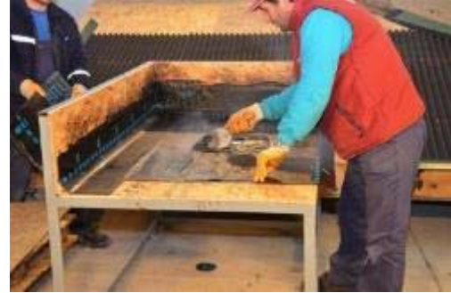
Resim 4.22: Kesilen Yalıtım Örtüsü ile Süzgeç Bandının Yapıştırılması
