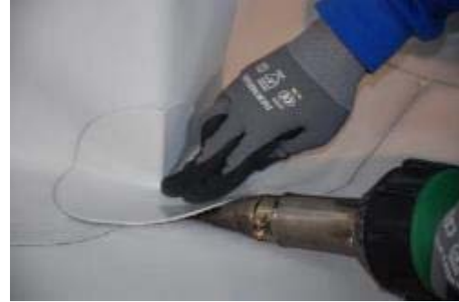
Resim 6.11: PVC Köşe Elemanının Montajı
