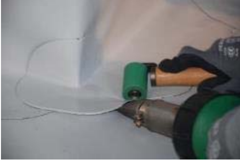
Resim 6.12: PVC Köşe Elemanının Yapıştırılma İşlemi
