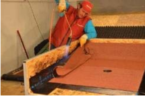
Resim 4.24: Mineral Kaplı Yalıtım Örtüsünün Duvar Yüzeyine Yapıştırılması
