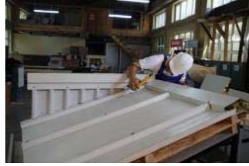
Resim 5.31: Sac Harpuřta Montajı
