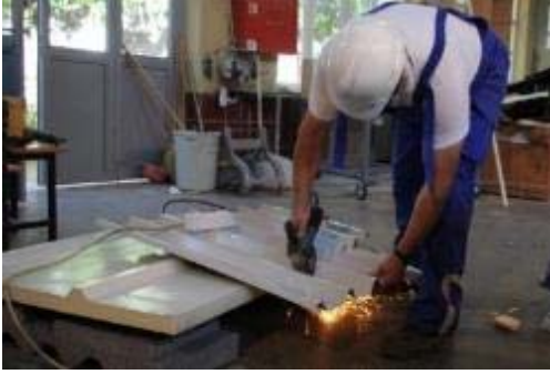
Resim 5.29: Trapez Sacın Kesilmesi
