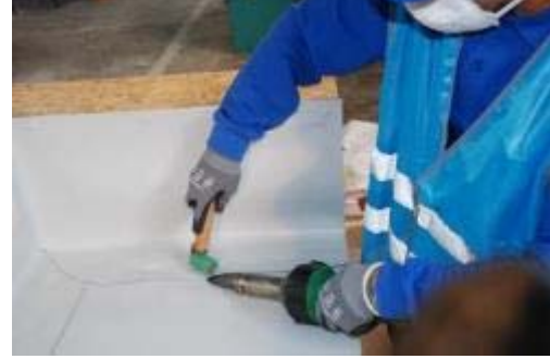
Resim 6.10: Parapet Duvarı Kaplaması Alt Detayı
