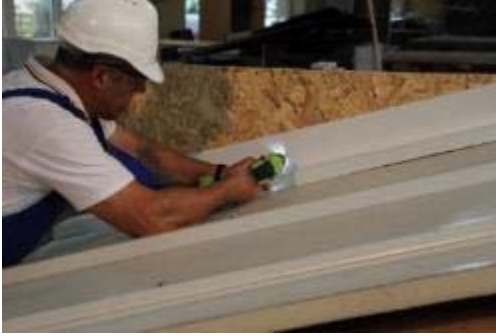
Resim 5.18: Sıva Dibi Profilinin Montajı
