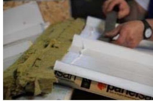
Resim 5.27: Bitümlü Mahya Süngerinin Yapıştırılması
