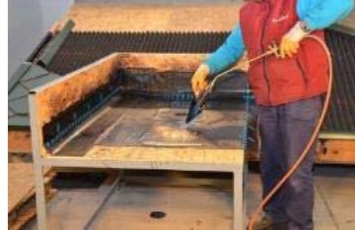
Resim 4.21: Kesilen Yalıtım Örtüsünün Isıtılarak Sıvı Hale Getirilmesi
