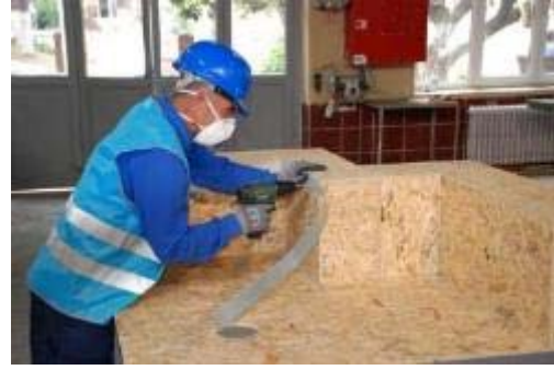
Resim 6.4: Laminasyon Çıtası Montajı
