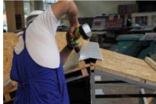
Resim 5.13: Alt Mahya Sacının Montajlanması
