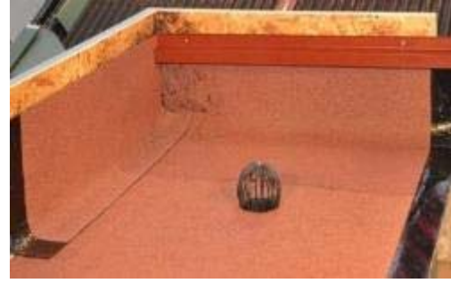
Resim 4.25: Mineral Kaplı Yalıtım Örtüsünün Sonlandırılması
