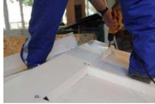
Resim 5.28: Mahya Sacının Montajlanması
