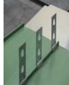
Resim 2.5: Çatılarda Kullanılan Kar Tutucu ve Kar Kırıcı Hazır Elemanlar
