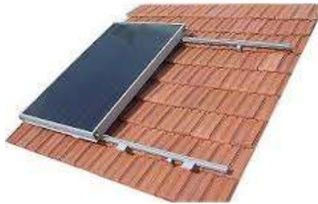
Resim 2.1: Güneş Kolektörlerinin Çatı Yüzeyine Uygulanışı
