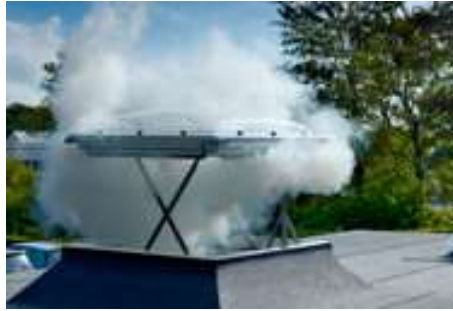
Resim 1.9: Yapı İi Duman Tahliyesi İin atıda Uygulanan Işıklık Örneđi
