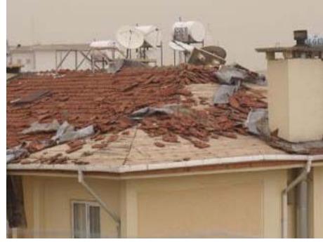
Resim 1.6: Olumsuz Hava Koşullarında Hasar Görmüş Kiremit Çatı Kaplaması
