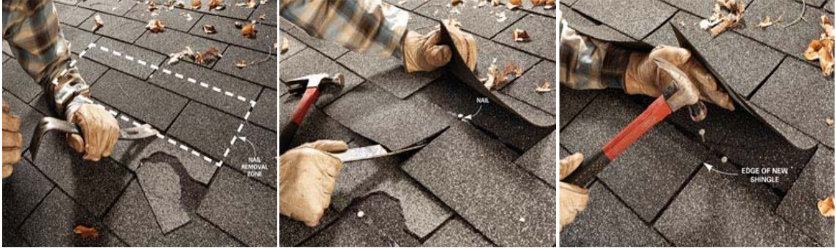
Resim 2.9: Şingil Çatı Kaplamasının Onarımı
