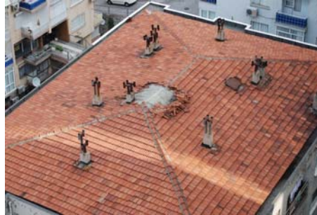
Resim 2.4: Kiremit Kaplamadaki Ayrılmalar
