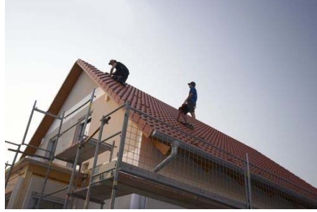
Resim 2.8: Bir Kiremit Çatı İçin Rutin Bakım-Onarım Çalışma
