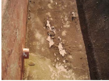
Resim 1.5: Malzeme artıklarından Dolayı Tıkanan Kanallar
