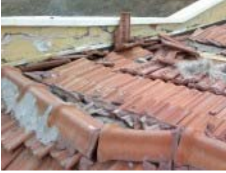
Resim 1.6: Olumsuz Hava Koşullarında Hasar Görmüş Kiremit Çatı Kaplaması
