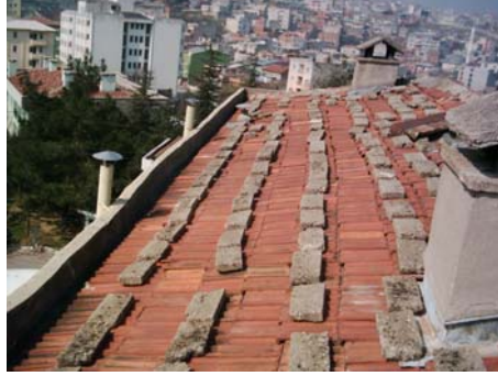
Resim 1.3: Doğru Tespit Edilmediği İçin Rüzgarda Uçmaması İçin Üzerine Yük Yerleştirilen kiremit Çatı Kaplaması
