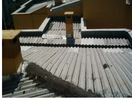
Resim 2.5: Yanlış Uygulama Olarak Harçla Doldurulan Mahya Hatları
