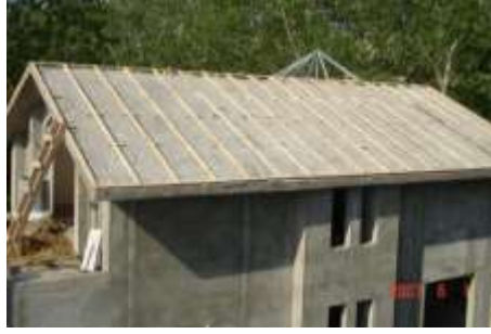
Resim 1.8: Betonarme Tařıyıcılı Çatı Uygulama Örneđi
