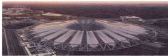
Resim 1.7: Işınsal Kablolü Örtü Sistemi Uygulama Örneđi
