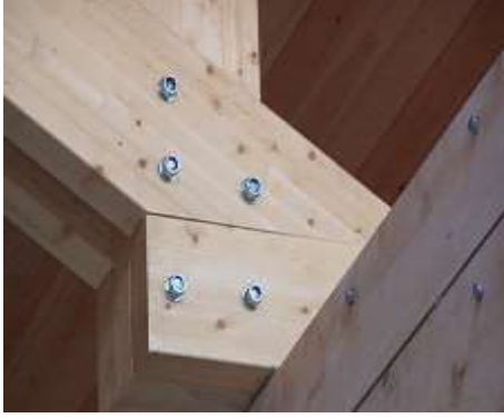
Resim 2.1: Lamine Ahşap Makas Örnekleri
