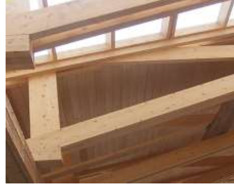
Resim 2.1: Lamine Ahşap Makas Örnekleri
