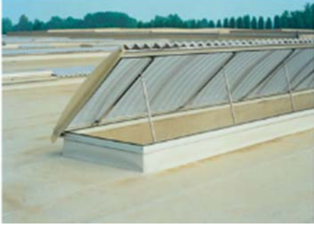
Resim 3.2: Çatı Pencereleeri
